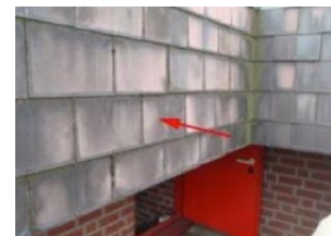
leien tegen de dakrand
