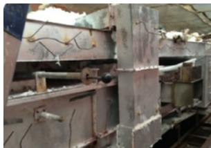
tussen de kanalen is koordpakking toegepast
