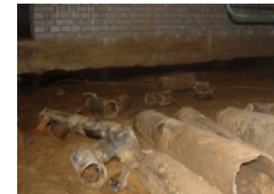
oude rioolleidingen in kruipruimte
