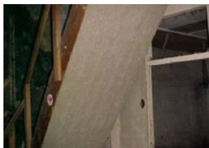
cementplaat op onderzijde trap (brandwerend materiaal)
