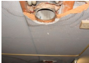
ontluchtingskanalen en ventilatieroosters
