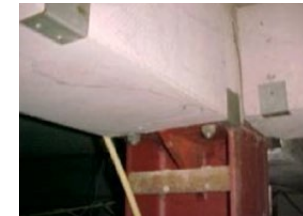
beplating tegen H-balk (staalconstructie)
