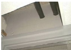
brandcompartimentering (vaak boven verlaagd plafond)
