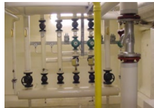
pakkingen tussen flenzen installatie
