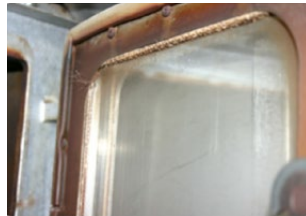
afdichtingskoord, toegepast bij brandwerende luiken, deuren en doorgangen
