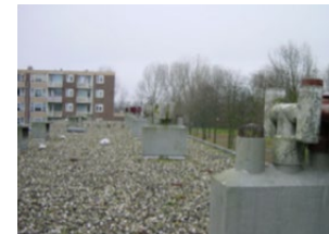
kappen of ontluchting op schoorsteen
