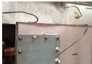
koordpakking ter afdichting van oven
