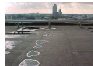
bitumen op plat dak (oude laag)
